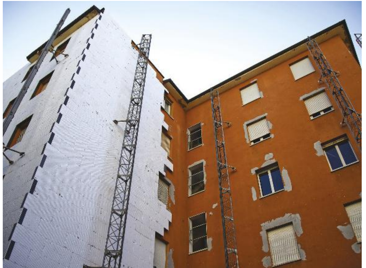
↑ Realizzazione di isolamento termico esterno per edifici per l'efficienza energetica
