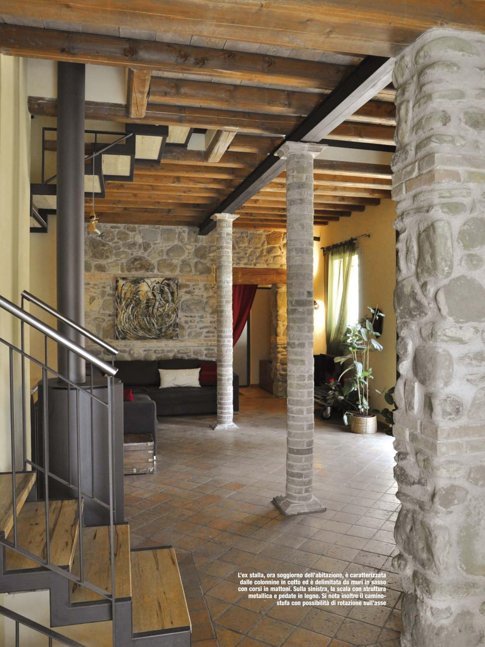
L'ex stalla, ora soggiorno dell'abitazione, è caratterizzata dalle colonnine in cotto ed è delimitata da muri in sasso con corsi in mattoni. Sulla sinistra, la scala con struttura metallica e pedate in legno. Si nota inoltre il camino-stufa con possibilità di rotazione sull'asse
