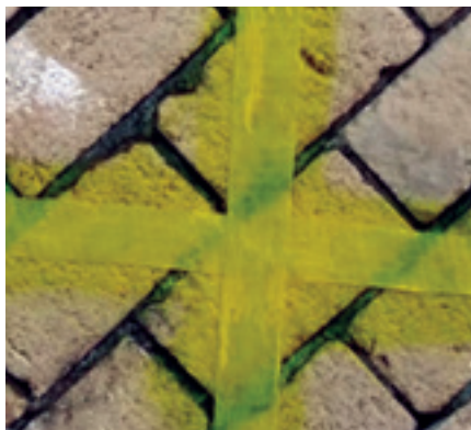
Fig. 1. Dettaglio rinforzo di una muratura con FRP
