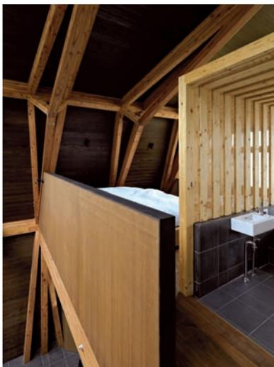
**In queste pagine: gli interni della villa SSK. La struttura portante lignea è a vista, ed è di un'essenza più chiara di quella adottata per le tamponature. Sotto: il particolare bagno con vista sull'oceano**
