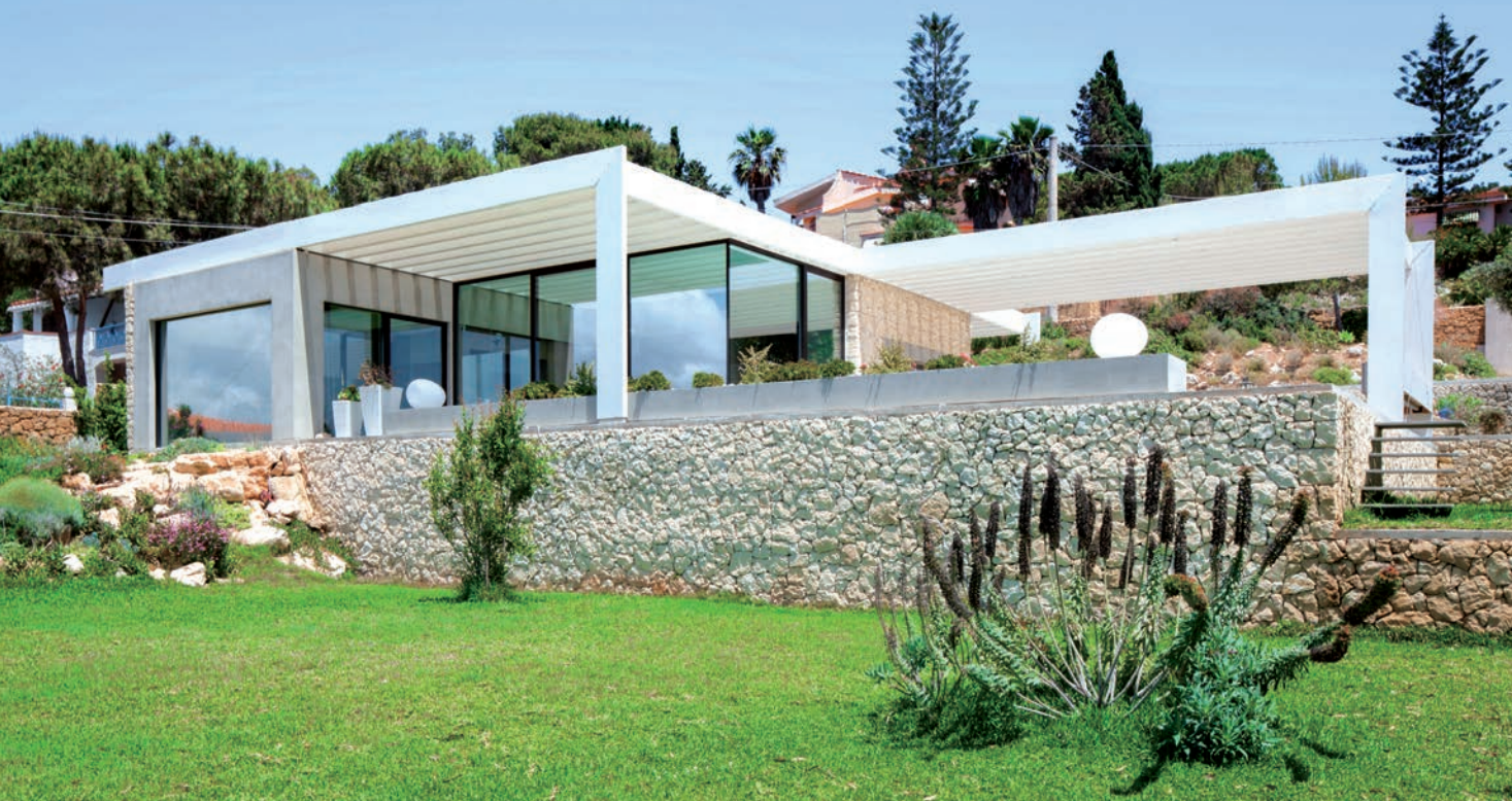
Sopra e a destra: la copertura in doghe di legno, a trave unica. Un elemento sospeso che nell'allungamento disegna il grande dehors. Un riparo dal sole da vivere in libertà, con una vista ininterrotta sul mare e sul verde. Sotto: la camera da letto con affaccio sul giardino
