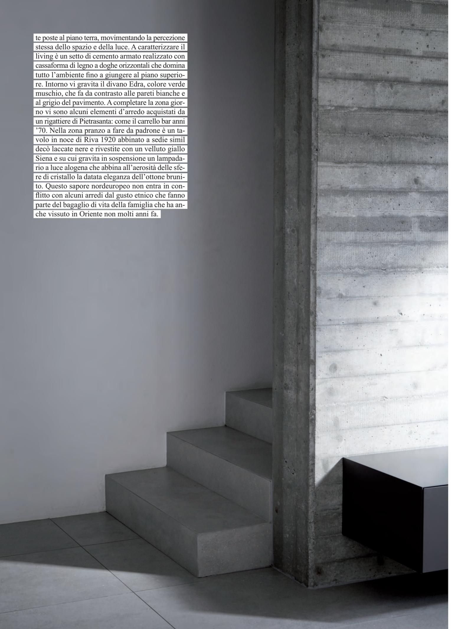
Due scorci della casa. A sinistra: il massiccio setto in cemento armato con funzione portante della scala che si trova sul retro. Sotto: il camino dalle linee moderne, costruito su una delle pareti del soggiorno
