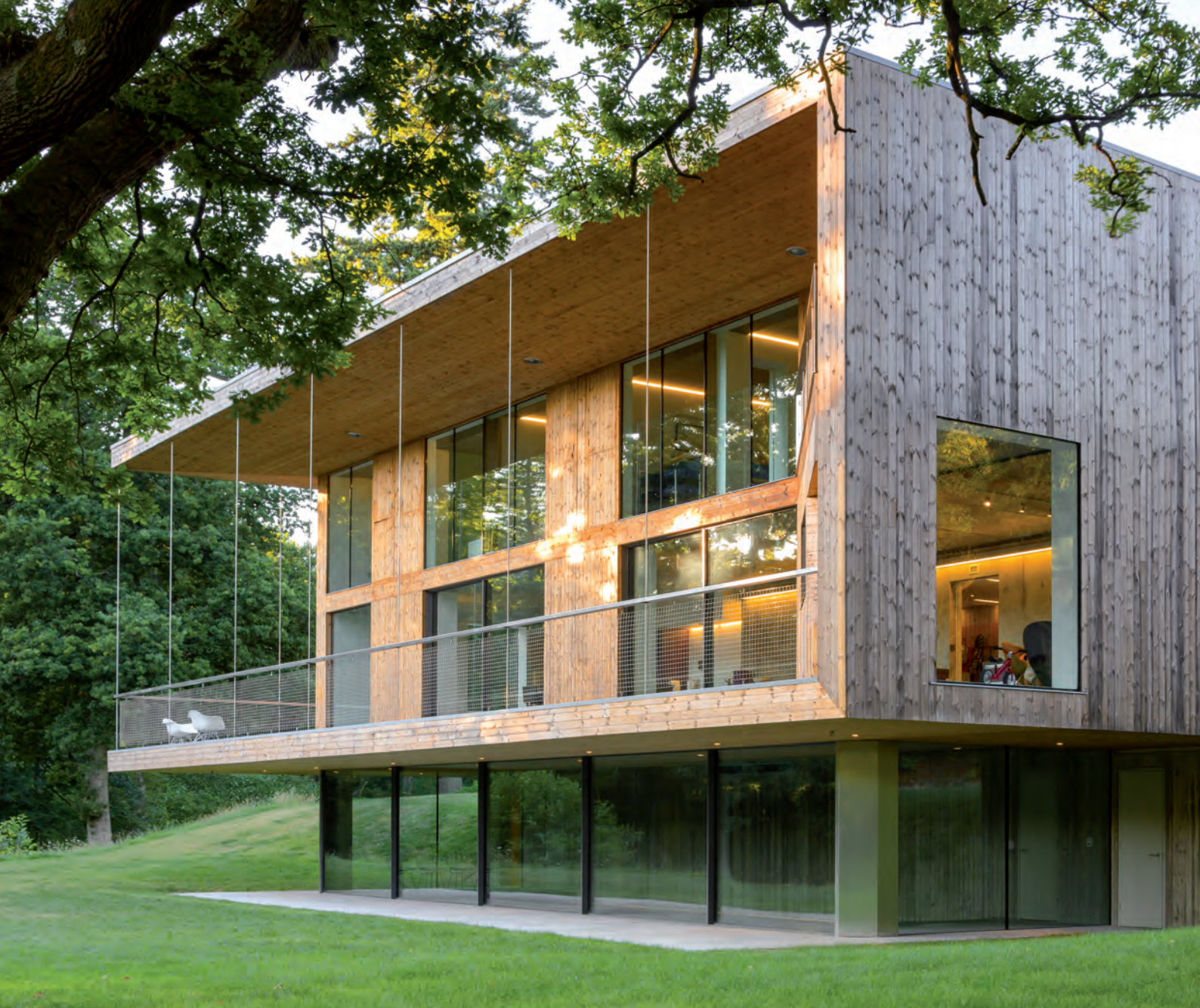
Sopra: la facciata posta a sud-ovest. Sotto: la facciata a est. In alto, a destra: l'interno del piano terra con gli ambienti spartani prospicienti la piscina e il giardino. Di fianco: la facciata posta a nord-est, con il rivestimento in corten e la passerella che conduce all'entrata principale
