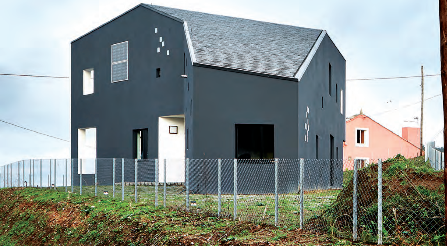
Sopra: il lato corto dello sfaccettato volume che caratterizza quest'abitazione. Sotto: il prospetto principale visto di scorcio. A destra: il prospetto posto a sud, caratterizzato da alcune chiostrine che offrono affacci diversi dalle finestre
