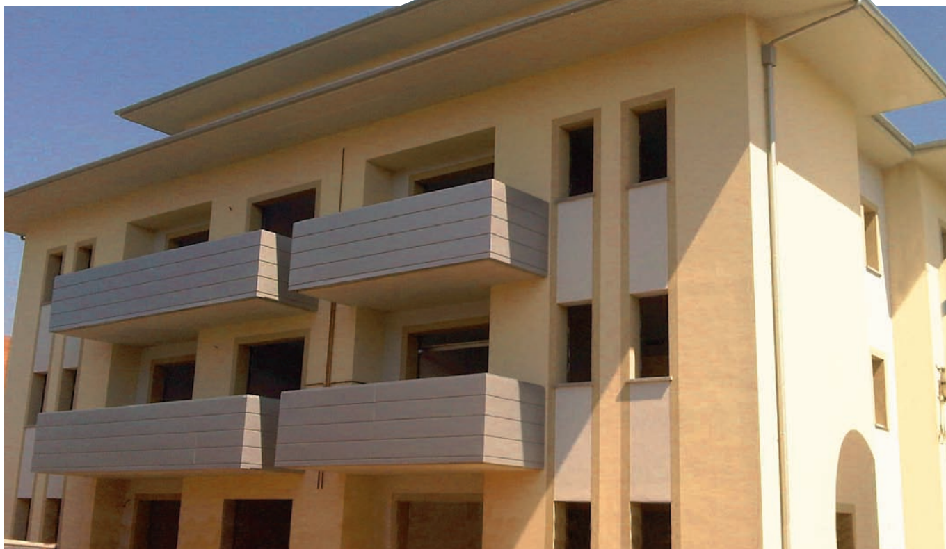
Sopra: nuovissima costruzione in via Due Madonne a Bologna. Sotto: Giardini di Persiceto a San Giovanni in Persiceto. La scelta di costruire e vendere direttamente gli immobili rientra in un discorso di qualità del servizio che offre la Costruzioni E. Dallacasa
