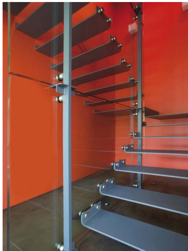
Sopra: particolare delle scale interne realizzate con pedata di metallo imbullonata alla lastra di vetro. Sotto: la scala esterna, posta nella corte – torre, che collega l'ambiente soggiorno realizzato nel patio con il disimpegno del primo piano. A destra: la corte – torre vista dalla finestra del salone del piano superiore
