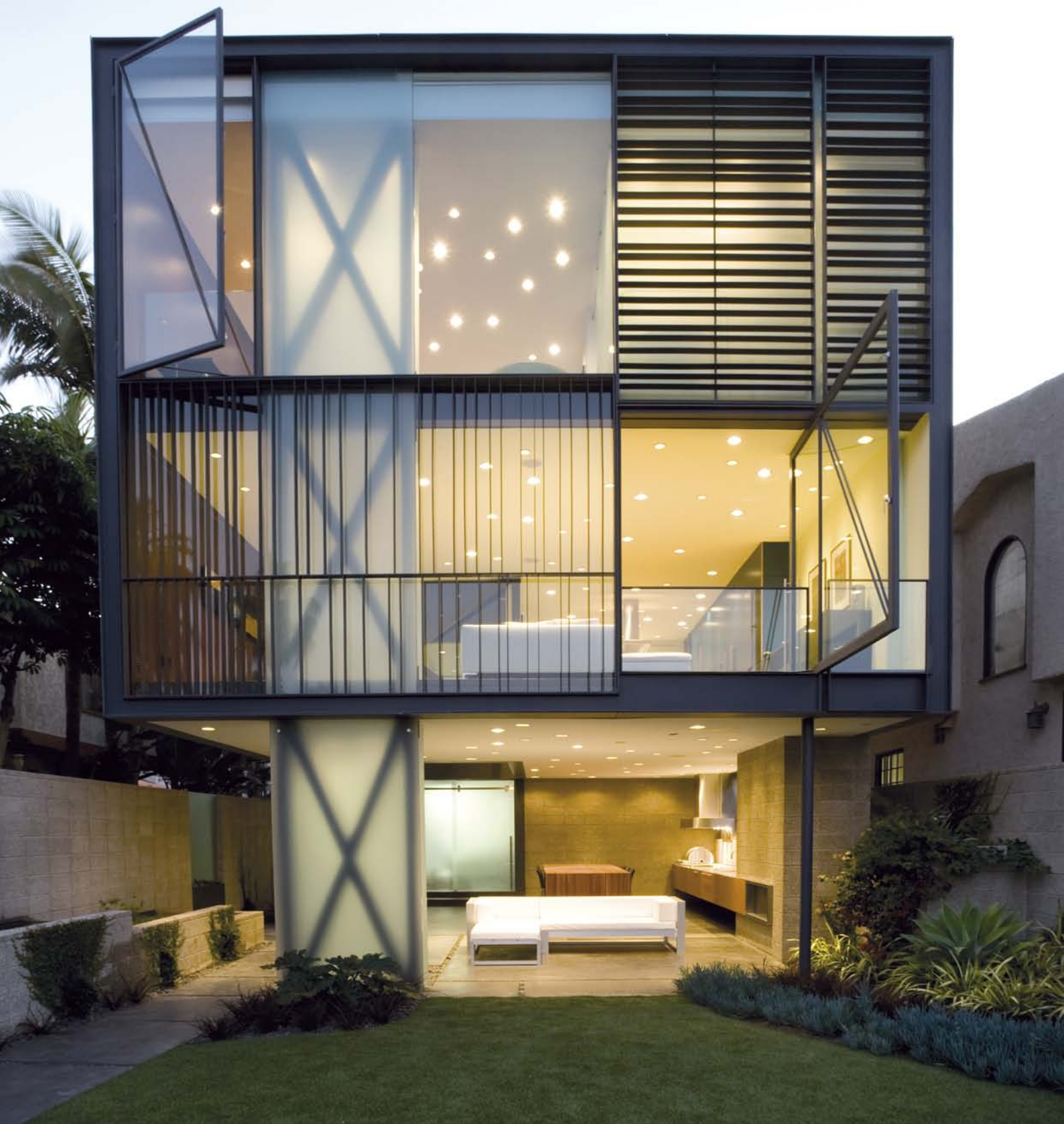
In questa foto: il prospetto principale, con la sua maglia tripartita variamente trattata. Il vetro, materiale prescelto, è schermato da diversi brise-soleil che fanno variamente vibrare le diverse partiture. A destra: il disimpegno posto tra le scale d'accesso e quelle di distribuzione interna
