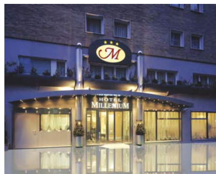
Bologna, Millen Hotel: in alto particolare della reception; al centro, dettaglio di una seduta nella hall. Sopra: particolare della facciata con l'ingresso alla struttura alberghiera, fortemente caratterizzato dalla pensilina ricurva retta da lesene sormontate dall'insegna dell'albergo
