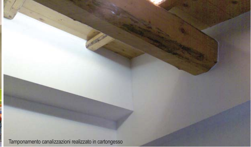
Tamponamento canalizzazioni realizzato in cartongesso
