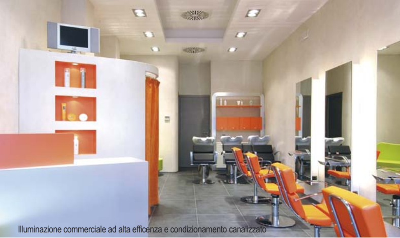
Illuminazione commerciale ad alta efficienza e condizionamento canalizzato
